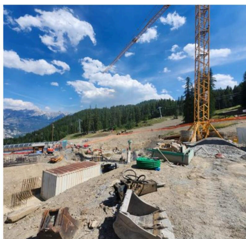
Le chantier de réaménagement du front de neige de Puy-Saint-Vincent est en cours. Le planning ambitieux annonce une fin des travaux cet hiver tandis que les prévisions raisonnables tablent sur l'été 2027. Photo Jean Adde-Soubra
